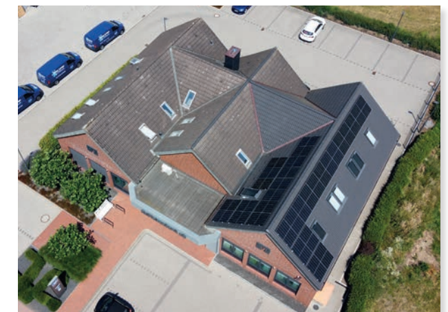
Die Photovoltaik-Anlage ist in verschiedene Himmelsrichtungen ausgerichtet, sodass zu jeder Tageszeit ein Nutzen erzielt werden kann.
